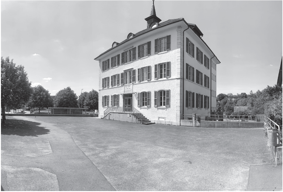
Cour d'école avant travaux
